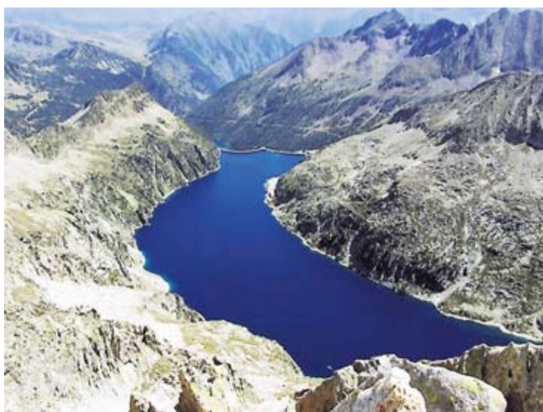
Le barrage retient 67 millions de m 3 d'eau. / Photo DDM archives
